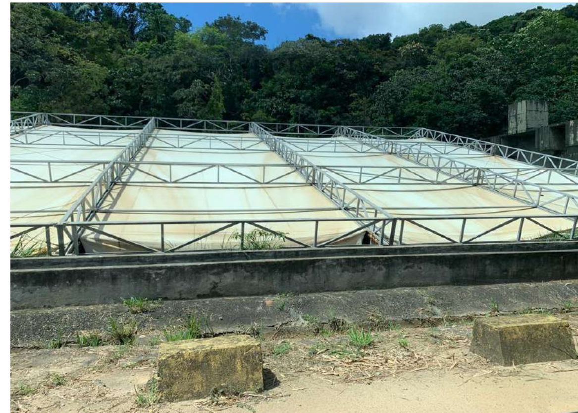
Figura 74. Local de armazenamento do lixiviado
