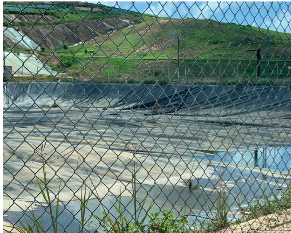
Figura 73. Lagoa de lixiviado
