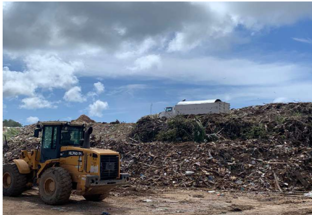
Figura 62. Ausência de compactação do Lixão do Quingoma
